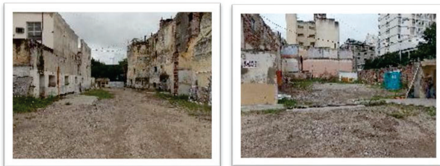
Figura 3.6. Estado de las parcelas en la primera inspección (Parcelas 18, 12, 9 y 11).
