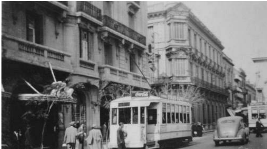
Figura 3.23. La calle Buenos Aires. En segundo plano y hacia el fondo se observa el edificio que ocupaba el lote 13 (construido en 1938).
