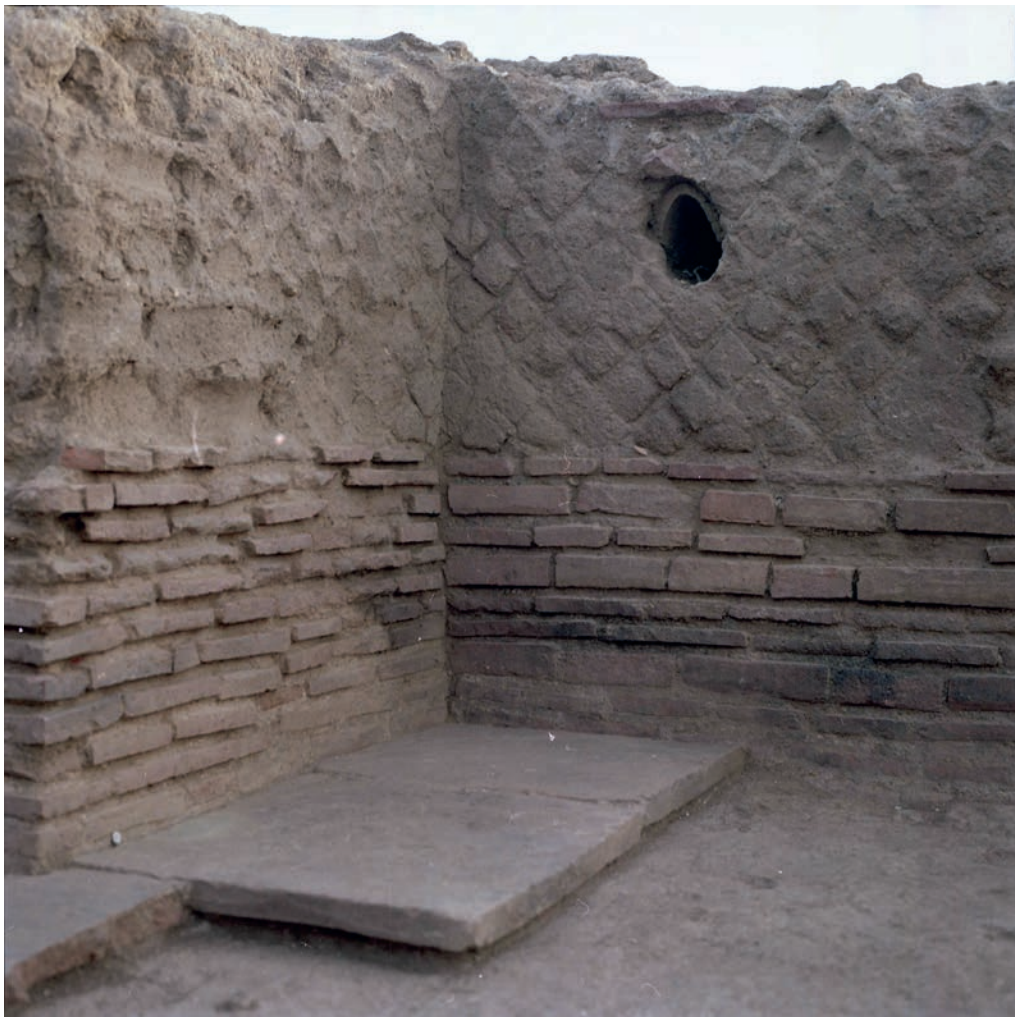
Figura 1.21. Punta Eolo, settore residenziale (ambiente 39): muri in opera mista (foto Archivio De Rossi).
