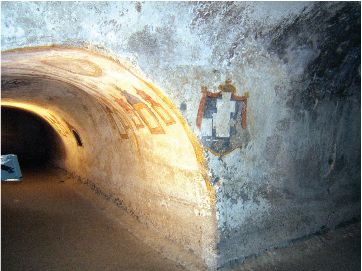
Figura 3. Una suggestiva immagine della 'Cisterna dei Carcerati', subito dopo la fine degli scavi e dei restauri, illuminata per le visite guidate.
