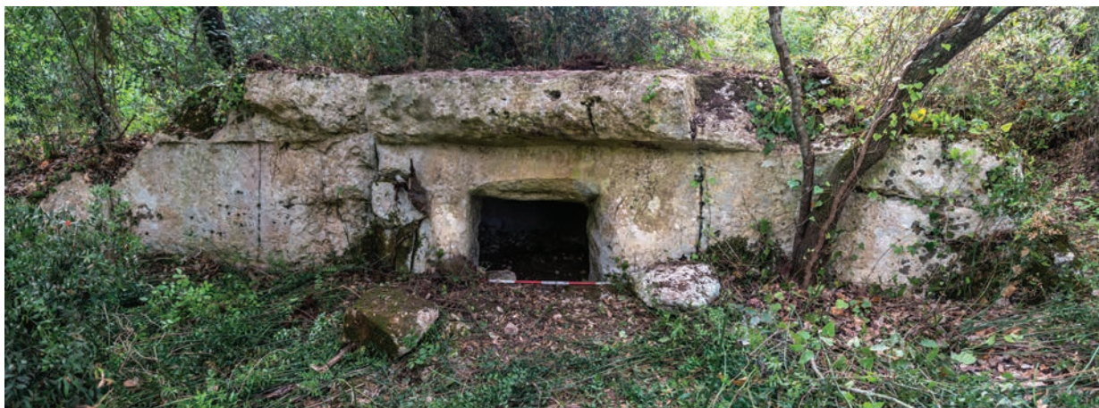
Figura 1. Contrada Arco (Noto). Sepolcro di Aristomenes. Prospetto (Foto E. Arioti)
