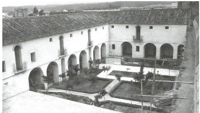
Fig. 11 y 12. El patio morisco antes y después de su restauración (Solano 2007).
