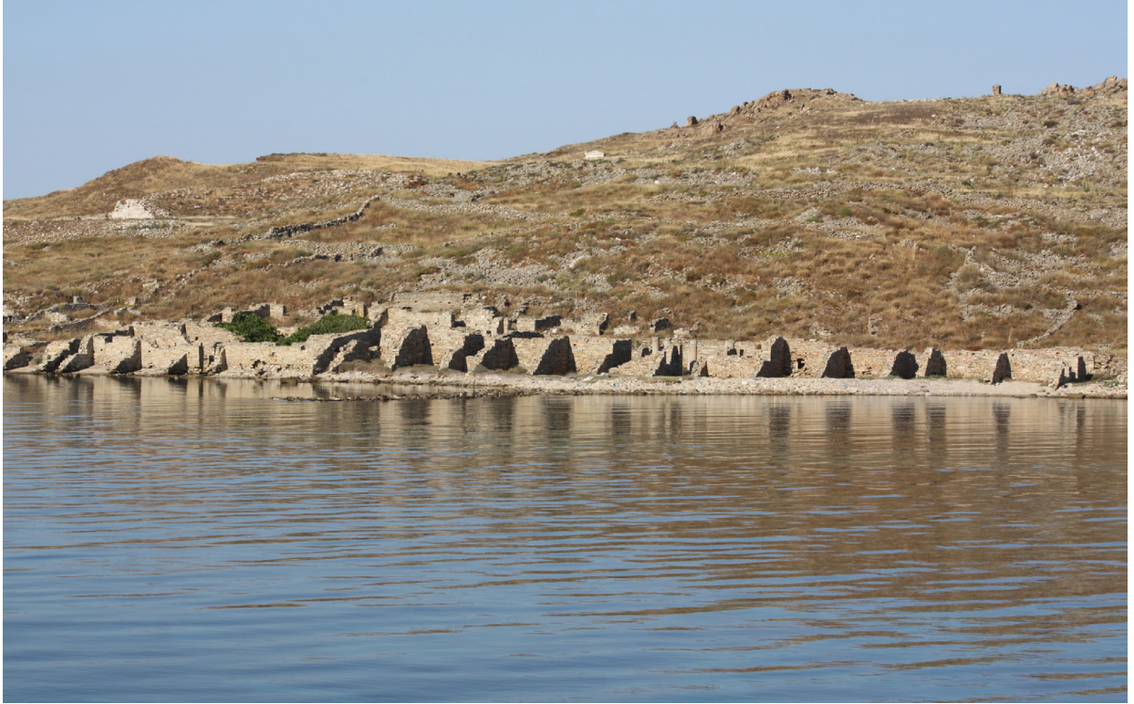
Figure 17 : Pièces polyvalentes de la façade ouest du Quartier Sud à Délos
