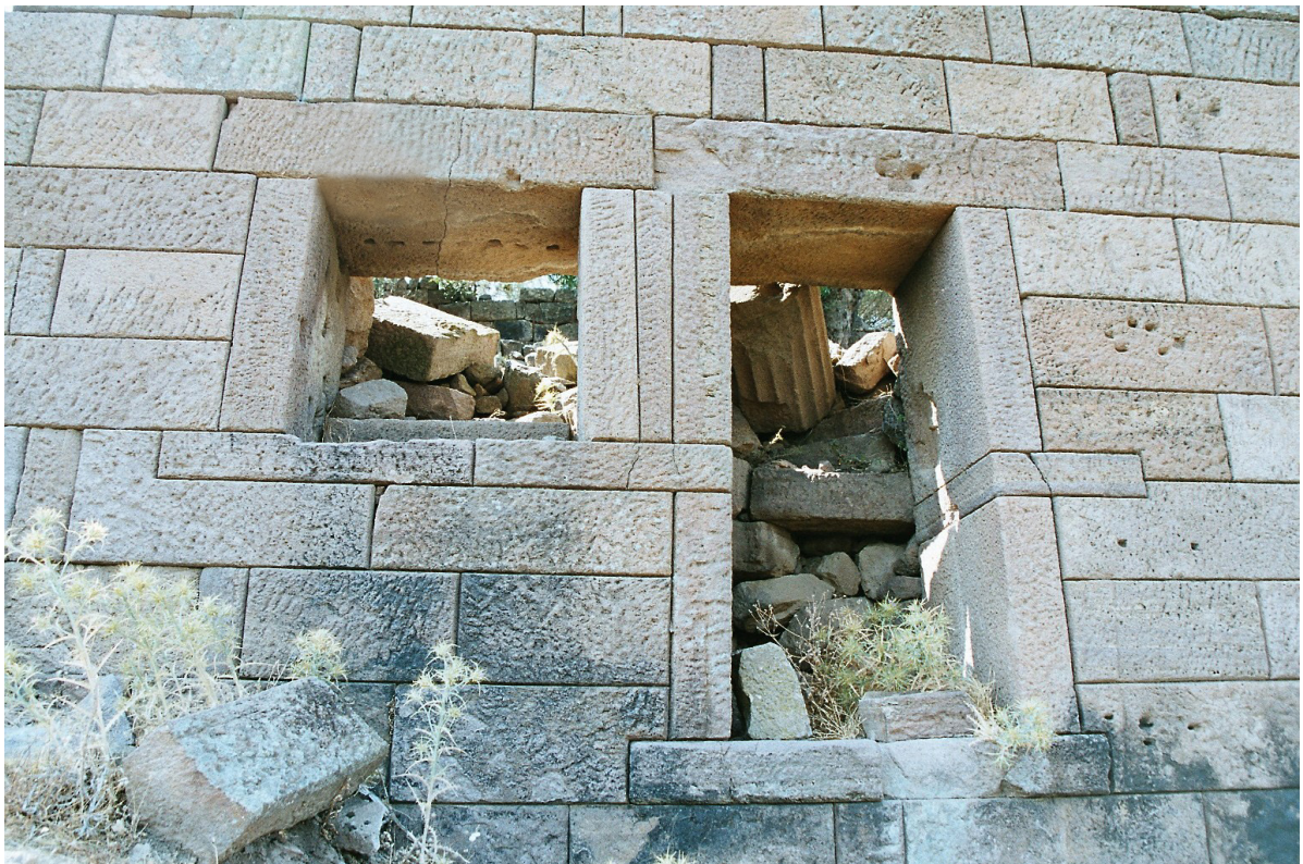
Figure 30 : Portes et fenêtres des pièces du portique d'Aigai
