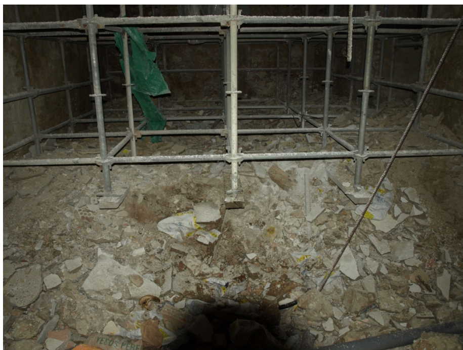
Figura 22. Cripta del Teatro Thebussem, Medina Sidonia, antes de su excavación. Foto: Manuel Montañés Caballero.
