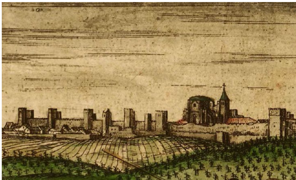
Figura 38. Torre de San Mateo en el grabado de Hoefnagel.
