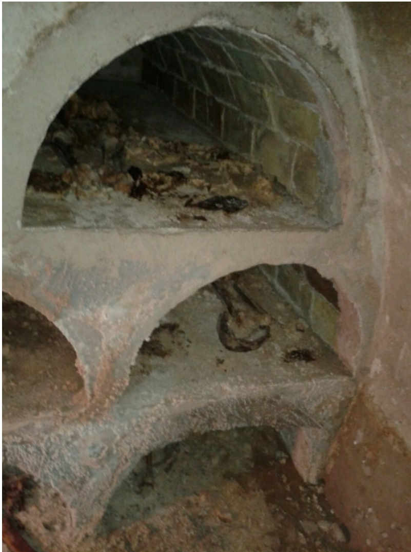
Figura 52. Estado en que se encontraban los nichos del templo de San Lucas. Foto: José Antonio González Leal.
