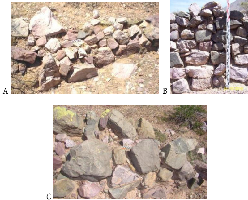
Figura 5.10. Formas y tamaños de los bloques. A. Bloques pequeños y grandes cuadrangulares y rectangulares de caras aplanadas. B. Bloques medianos rectangulares de caras aplanadas. C. Bloques pequeños medianos y grandes irregulares.
