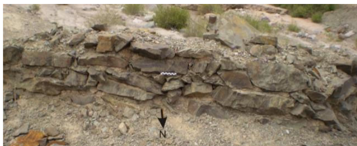
Figura 4.9. Detalle de uno de los muros del sector sur de Las Ventanitas.
