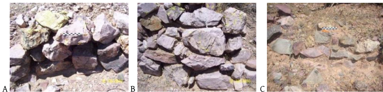
Figura 5.15. Sedimento acumulado entre los bloques. A. Ausencia. B. Escasa acumulación. C. Acumulación abundante.
