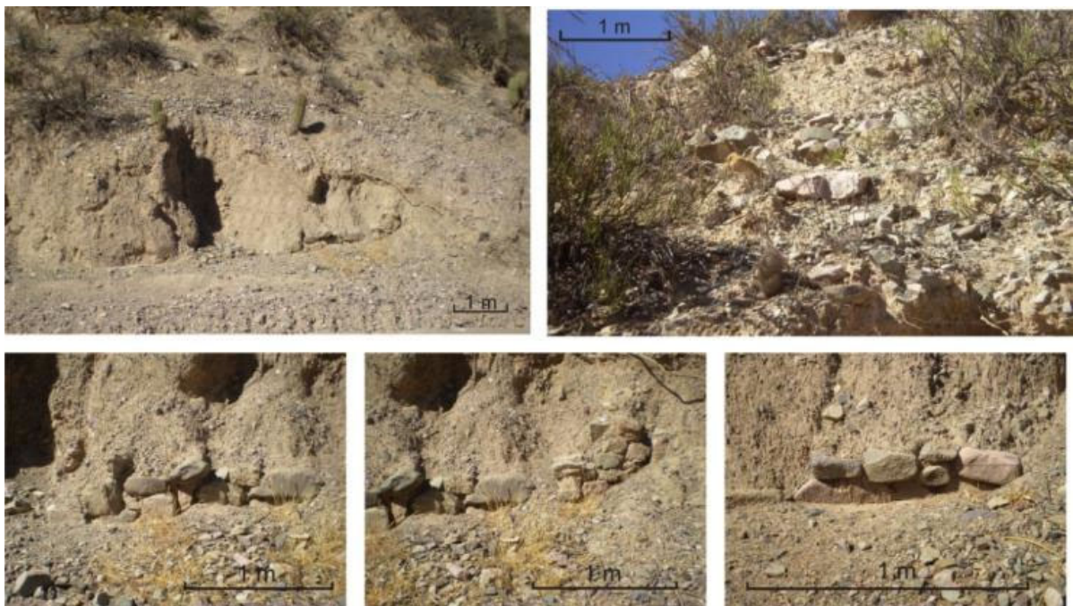
Figura 4. 21. Vista general de Quebrada de Cárcel 1 y detalle de los muros.
