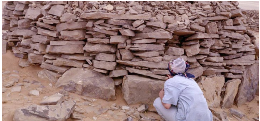
Figure 14 : Photographie à Jebel Jidran des aménagements pour renforcer la base des parois externe. ©TSH
