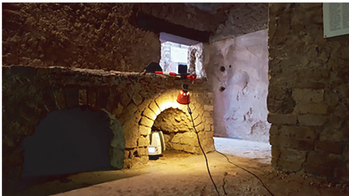
Figura 8 - Villa San Marco, ambiente [36]. Acquisizione di nuvola di punti della muratura più bassa appoggiando direttamente lo strumento sui piani pavimentali.
