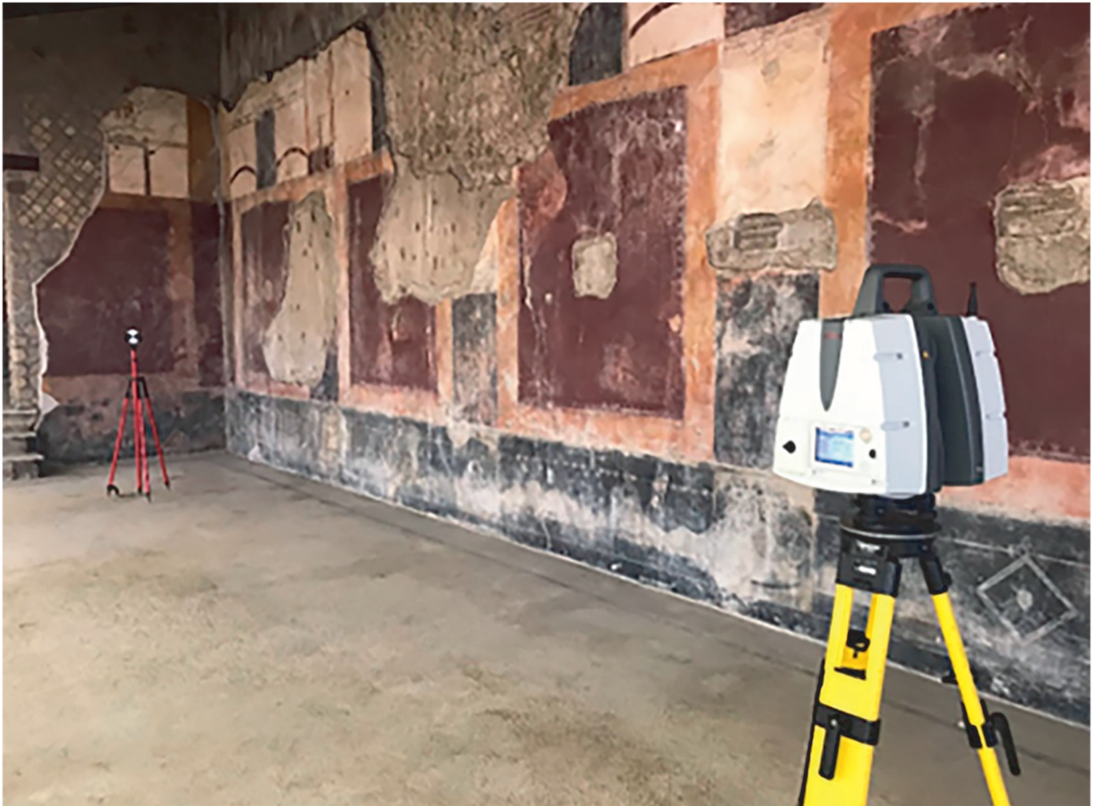
Figura 3 - Villa San Marco. Il Laser Scanner Leica P30 utilizzato nella fase per il rilievo architettonico.
