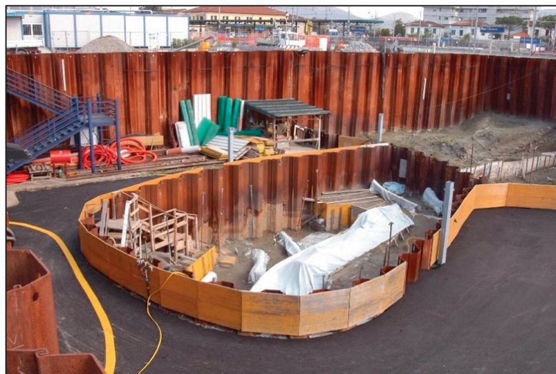
Figura 2 - Area 1 (a destra) e area 5 (al centro) in corso di scavo (foto di repertorio).
