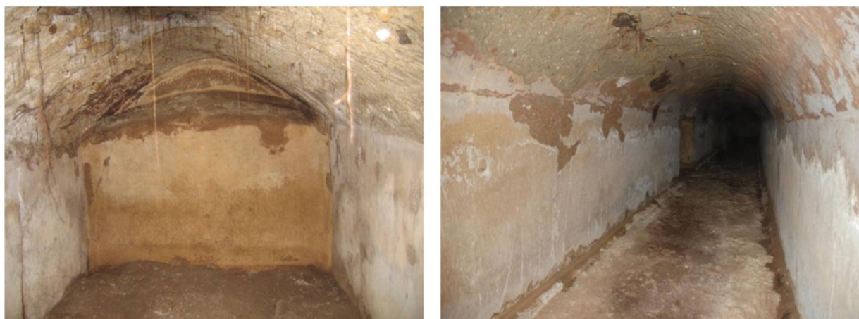
Figure 4: Particolari della cisterna C2 della Villa dell'Ambulatio.
