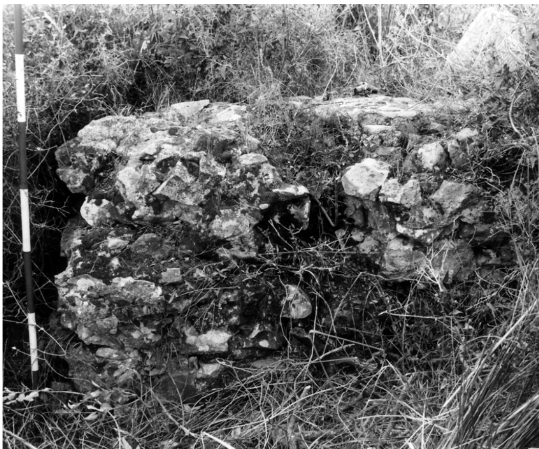
Figure 11 – L'acquedotto: struttura in situ .
