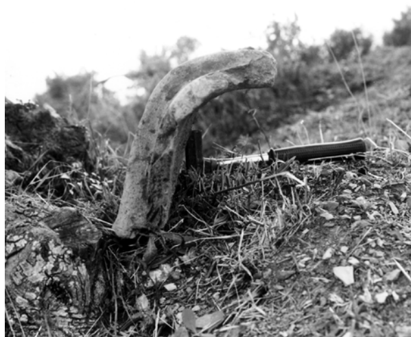
Figure 9 – L'acquedotto: canale ad 'U'.
