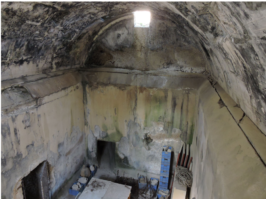
Figure 14: Panoramica dell'interno di una delle Cisterne delle cd Stanze di Venere con ben visibile il muro di rivestimento funzionale alla riconversione in serbatoi di questi ambienti (foto: D. De Simone).
