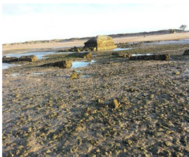
Figura 46: 2013. Unidad constructiva A con restos de los pretiles del Camino del Arrecife (La Albufera en bajamar) Fotografía de Francisco Gherzi García.
