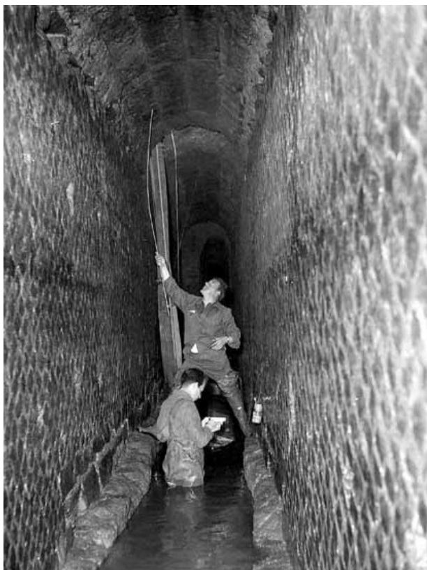
Figura 3 - Salone. Ispezione di ACEA presso Vigna Vignetta (1965). Braccio tributario in muratura. Foto 04346 BNT di proprietà di ACEA S.p.A., da Archivio Storico ACEA S.p.A (riprodotta per concessione di ACEA S.p.A., ogni diritto riservato).
