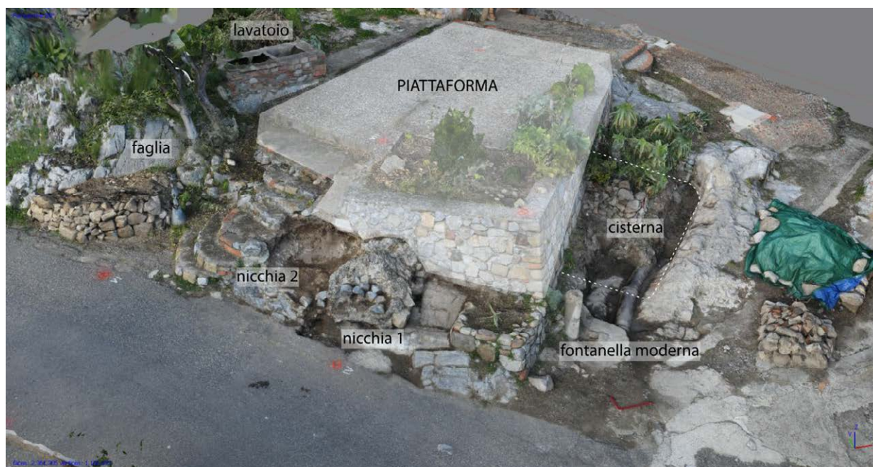
Figura 4 - Settore dell'intervento di pulizia e rilievo in via Teatro Greco.
