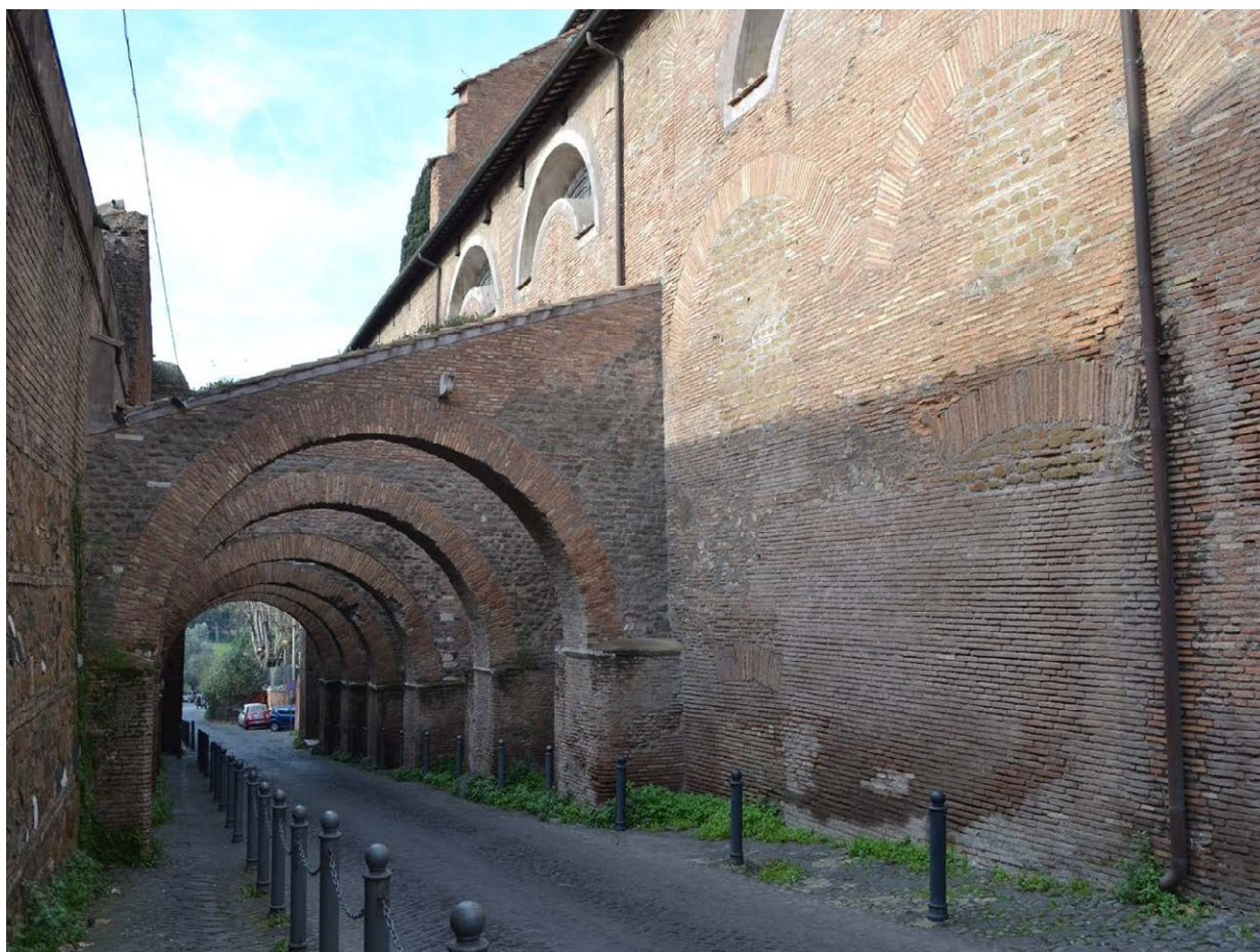
Figura 2 - Dettaglio dell'attuale Clivo di Scauro.
