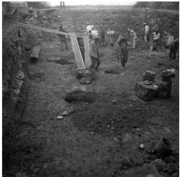
PAL.26.11 | AMARAS | pictures | 1 side | 1941 | inv. no. 8281 | Palermo, Biblioteca Nazionale : view of the construction site for the refuge. | 'Palermo (Biblioteca Nazionale). Scavo ricovero. Tombe' (courtesy of Museo Archeologico Regionale 'A. Salinas' ).
