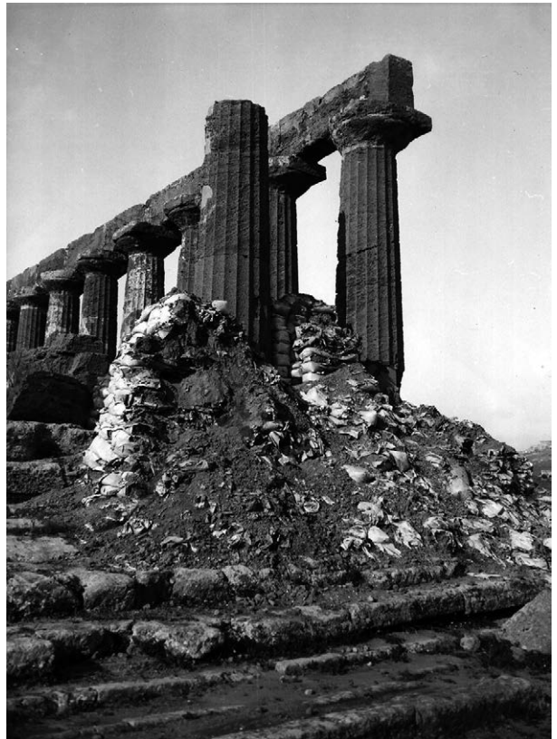
AGR.11.25 | ASSPAMON | pictures | 1 side | inv. no. 395 | 6x9 | Temple of Hera: melted sandbags | 'Agrigento. Tempio - Particolare' (courtesy of Soprintendenza ai Beni Culturali e Ambientali di Palermo ).
