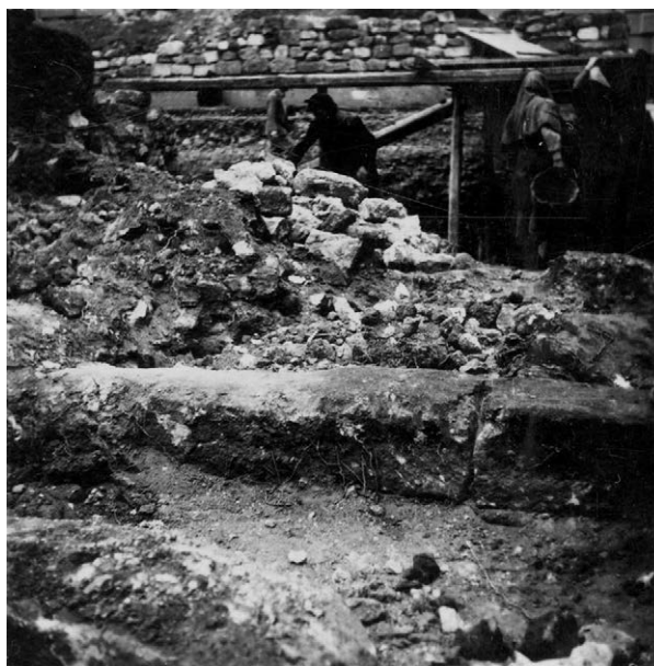
PAL.26.27 | AMARAS | pictures | 1 side | 1941 | inv. no. 8227 | Palermo, Piazza Sett'Angeli: view of the construction site. | 'Palermo (piazzetta Sett'Angeli) - Ruleri romani - Scavo ricovero' (courtesy of Museo Archeologico Regionale 'A. Salinas').
