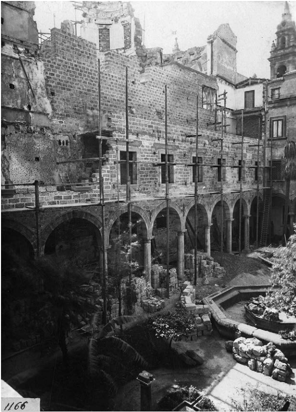
PAL.26.48 | AMARAS | pictures | 1 side | 1943 (?) | inv. no. 8018 | 13x18 | Palermo, National Museum: scaffolding to renovate the destroyed wall. | 'Museo di Palermo. Rifacimento dell'edificio dopo i bombardamenti della guerra' (courtesy of Museo Archeologico Regionale 'A. Salinas').
