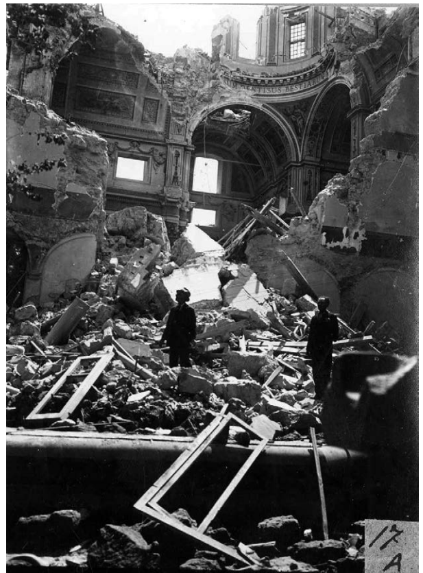
PAL.26.51 | AMARAS | pictures | 1 side | 1943 | inv. no. 8042a | 13x18 | Palermo, National Museum: view of the destroyed area. | 'Museo di Palermo. Rifacimento dell'edificio dopo i bombardamenti della guerra' (courtesy of Museo Archeologico Regionale 'A. Salinas').
