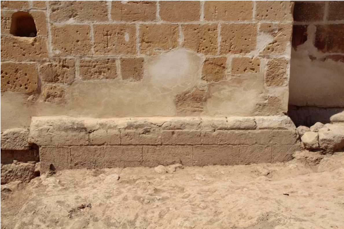
Figura 6.27. Zócalo del ábside de la ermita.
