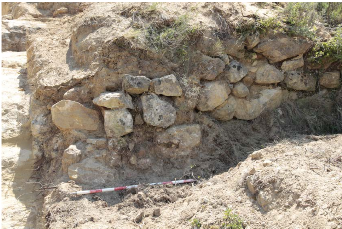
Figura 5.8. Muros de contención de las terrazas agrarias de Castrijo.
