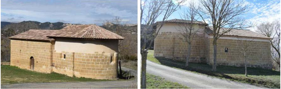
Figura 4.2. Fotografías exteriores del edificio religioso, desde el sur (izquierda) y el norte (derecha). Fuente: José Rodríguez.
