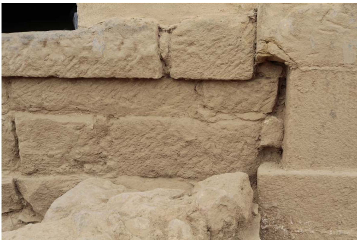
Figura 6.8. Superficie de contacto entre el muro 2027 del edificio E2, el zócalo de la iglesia medieval y su reconstrucción en época moderna.
