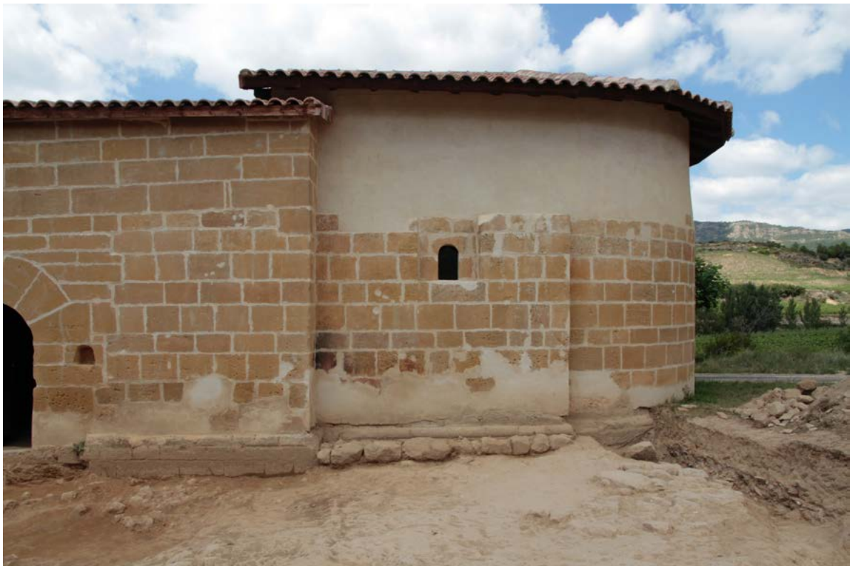
Figura 6.14. Aparejo del ábside de la ermita de Santa Lucía.
