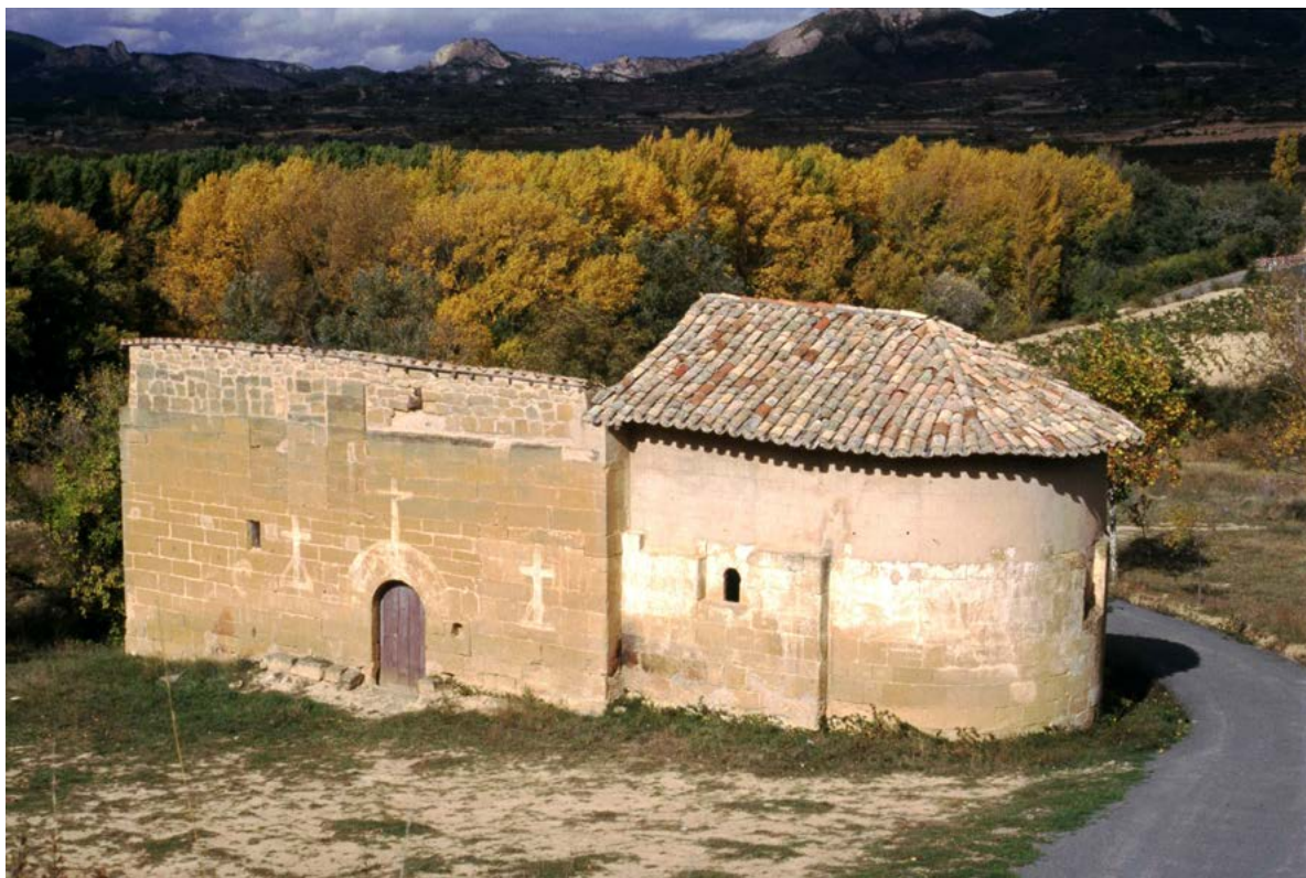
Figura 6.9. Vista general de la iglesia de Santa María antes de la restauración más reciente.
