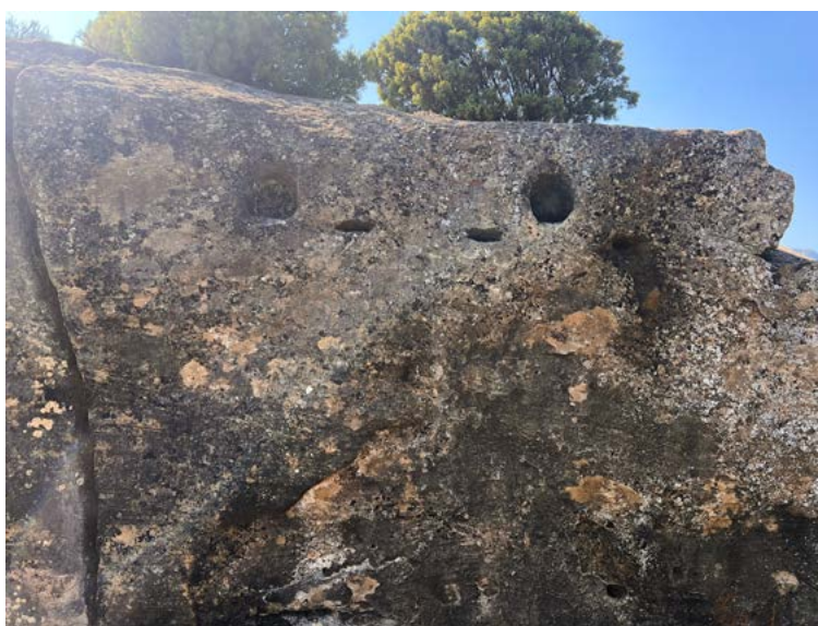
Figura 2.46. Construcciones domésticas en Santa María de la Piscina (La Rioja).
