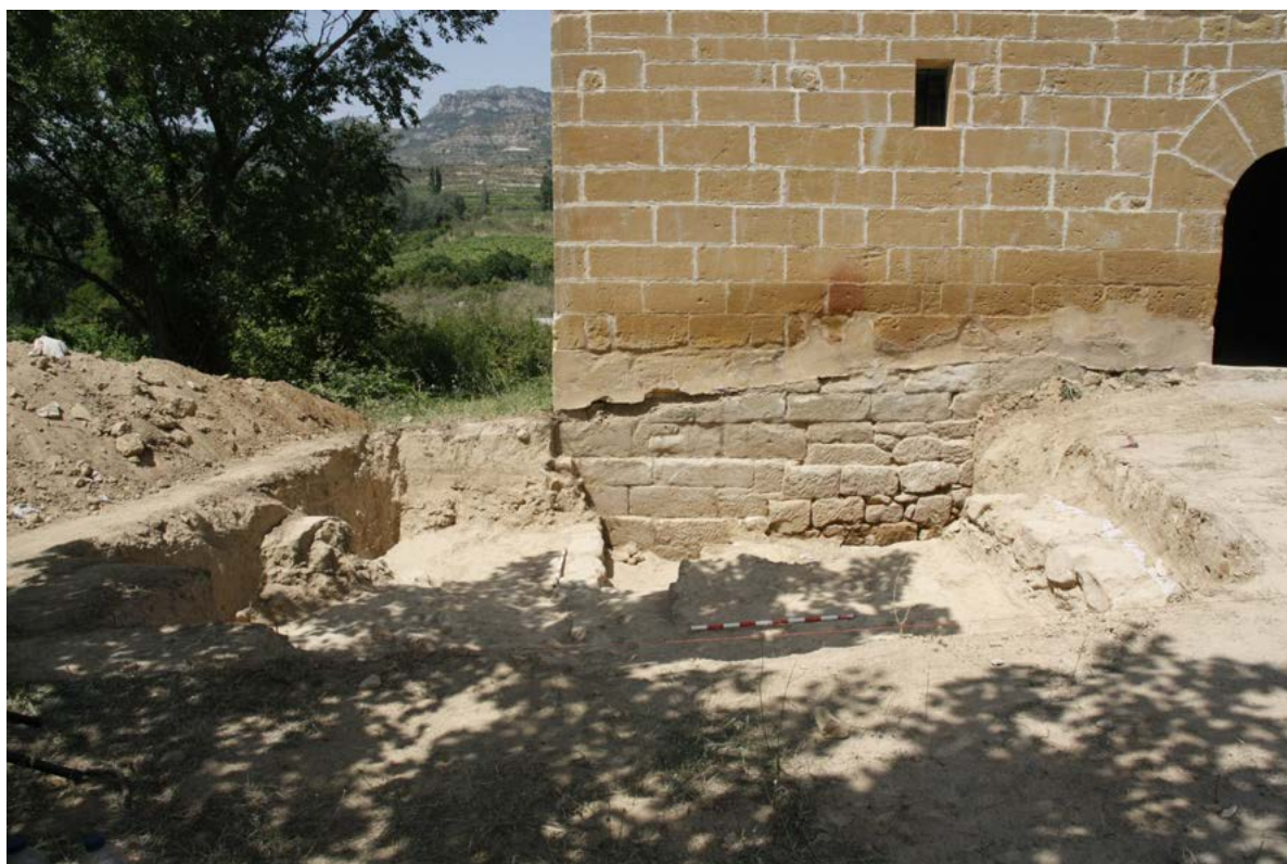
Figura 5.45. Apertura del sector 2000 en su parte occidental.
