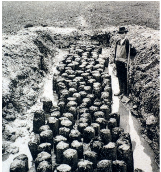
81. Pile grid as foundation of the Raetian wall at Dambach Pfahlrost als Fundament der Limesmauer im Kreutweiher beim Kastell Dambach
